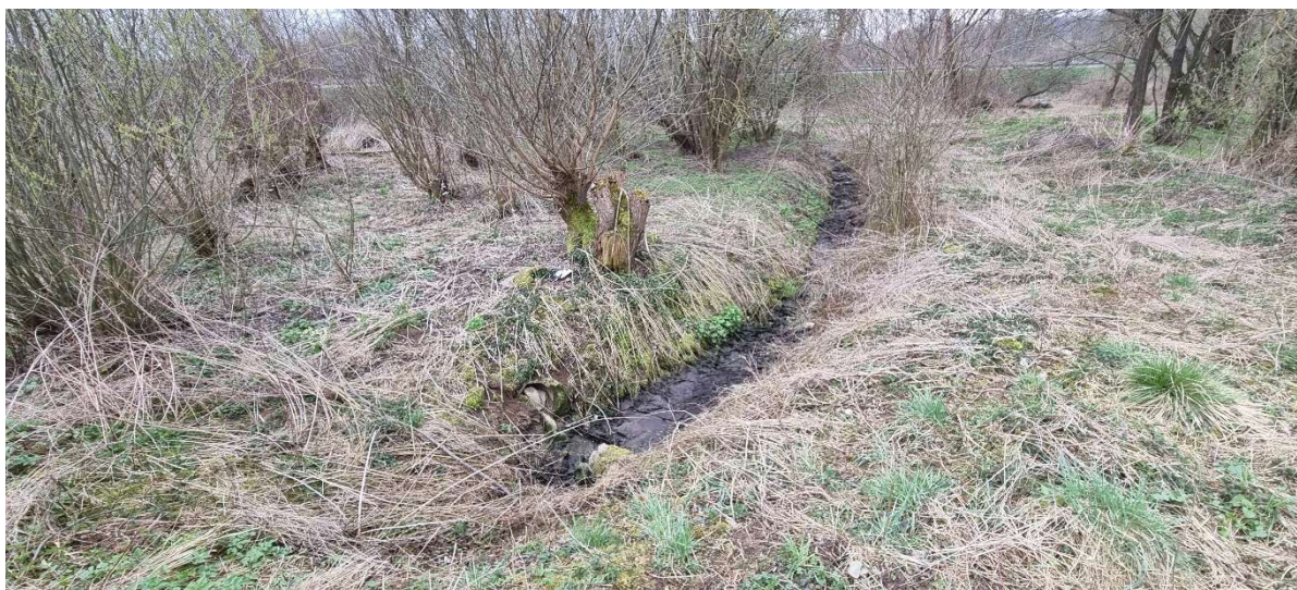
Pohled na stávající přerušení potrubí - odtok vyčištěné odpadní vody z ČOV betonovým potrubím DN 300 a náletové dřeviny, většinou vrba jíva ( Salix caprea )
